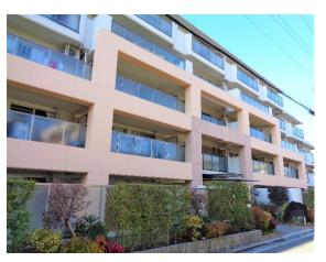
【耐震改修(アウトフレーム工法)の事例】
