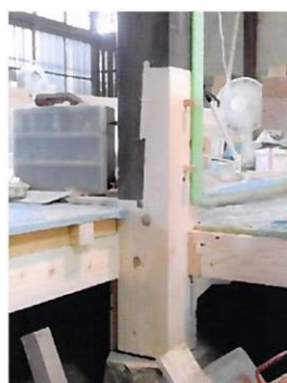
柱等の劣化修繕
