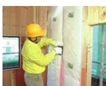
外壁への断熱材設置 （写真提供：硝子繊維協会）
