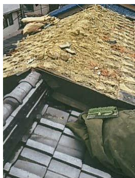
屋根の軽量化（屋根の葺き方を 土葺き⇒引っ掛け桟瓦葺きに変更）
